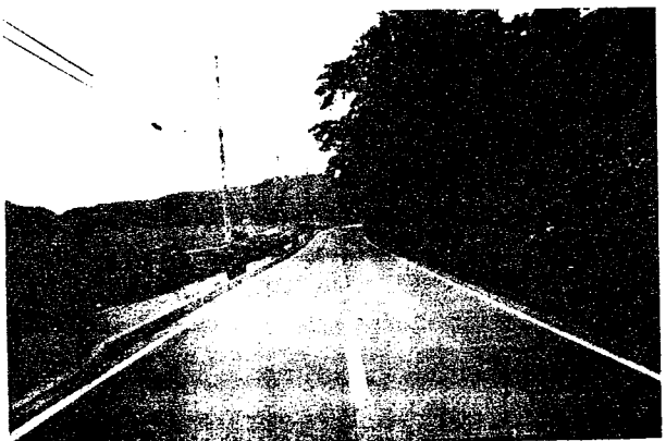
写真-2 舗装補修前の県道
