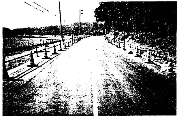
写真-5 舗装工事完了時
