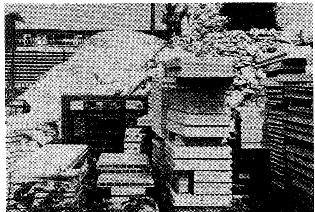
写真-1 ALC板製品とその廃材
