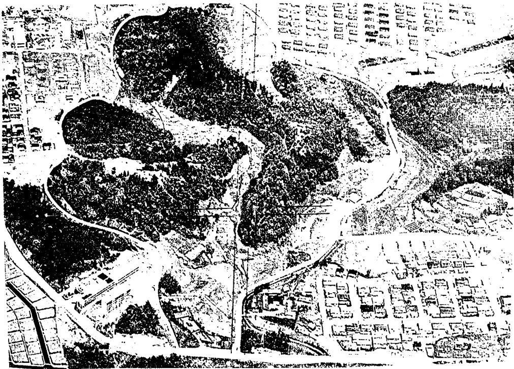
図-5 造成工事前の写真(事例2)
