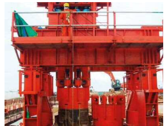
(b) 油圧ジャッキシステム
