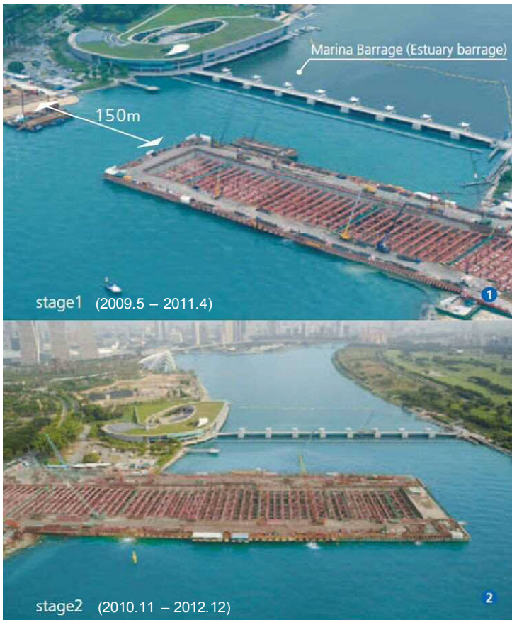
図-3 仮締切りと分割施工の状況
