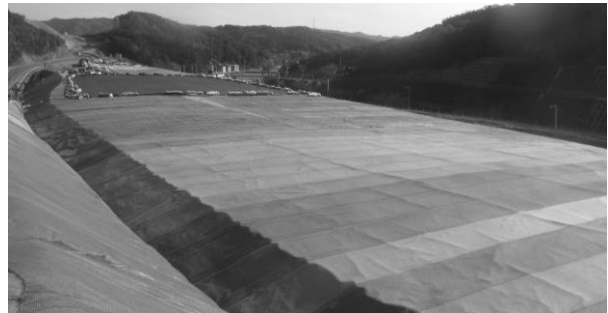
写真-1 シート施工状況 (カバーシステム)
