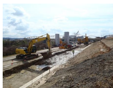
写真-4 安定処理工の施工状況
