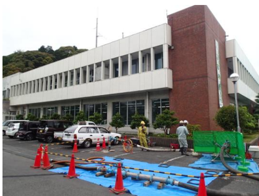
図-8 充填状況(右：充填孔、左：充填感知センサ挿入、手前：スティックミキサー)
