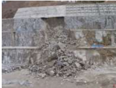
【大規模崩落状況】
