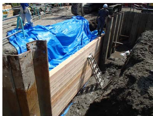
写真-5 床付け確認状況
