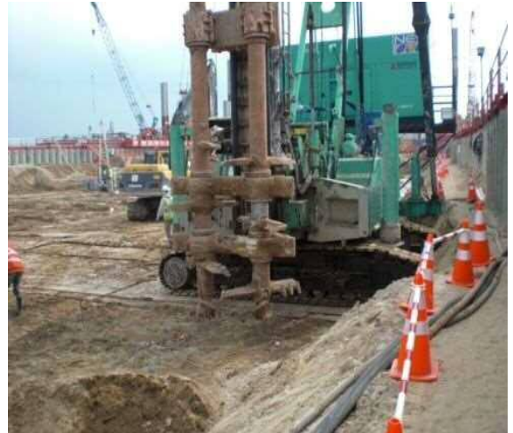
図-9 CDM 施工状況(陸上2軸機)
