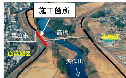
写真-1 ECウォール施工位置
