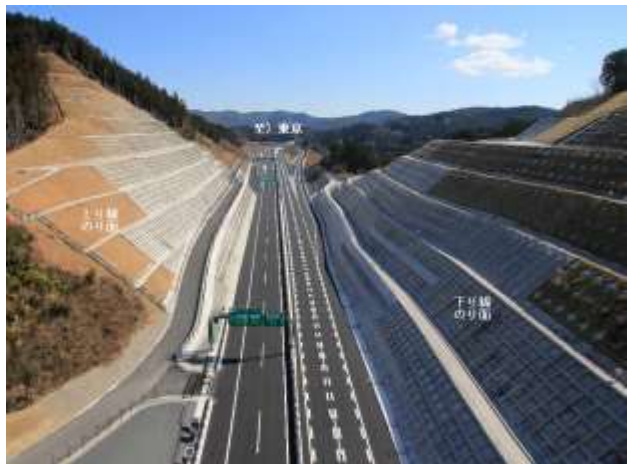
写真-4 県境切土のり面完成写真
