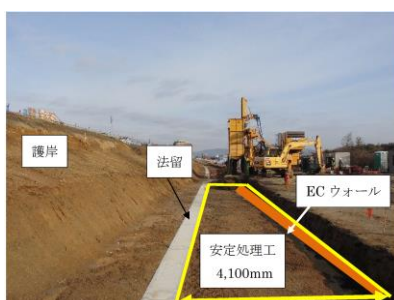
写真-3 安定処理工のエリア
