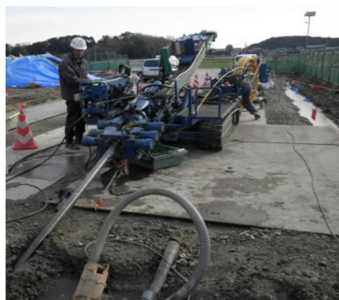
写真-3 施工状況
