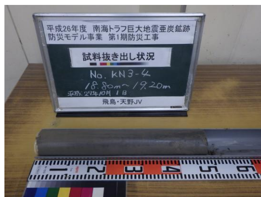
図-9 確認ボーリング充填材コア採取
