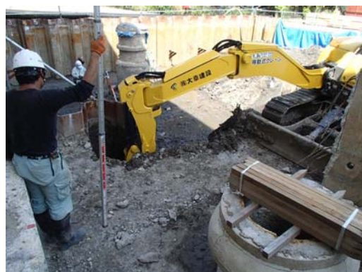
写真-4 開削状況
