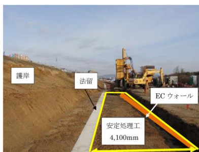
写真-3 安定処理工のエリア
