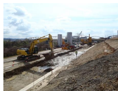
写真-4 安定処理工の施工状況
