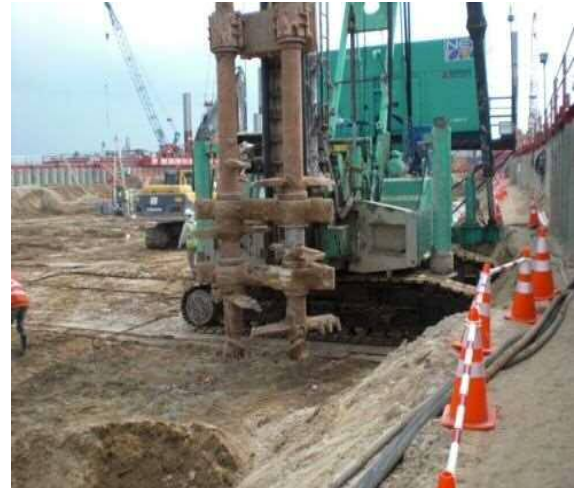
図-9 CDM 施工状況(陸上2軸機)
