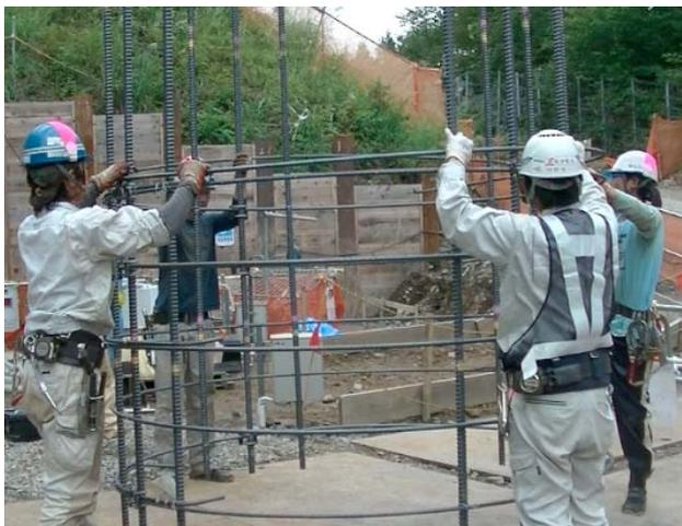
写真-8 孔外作業スペースでの最低限の鉄筋籠組立状況
