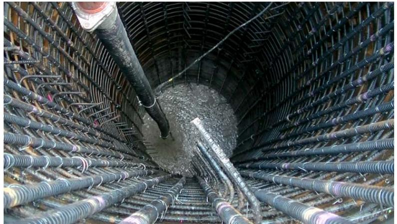
写真-14 土留と打設ホースにバイブレータを設置した締固め状況
