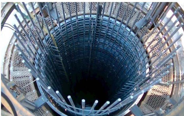
写真-12 鉄筋籠挿入完了状況（完成）
