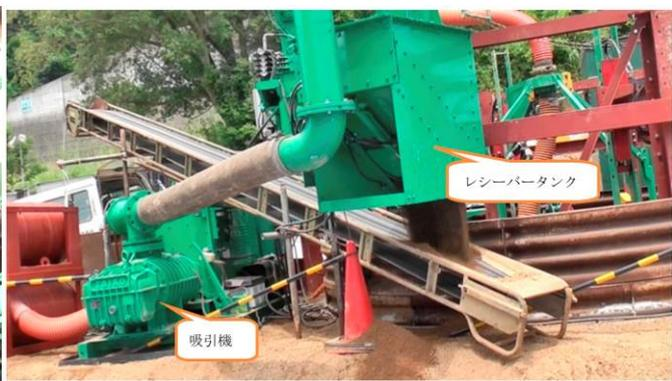
写真-3 バキュームによる土砂搬出状況
