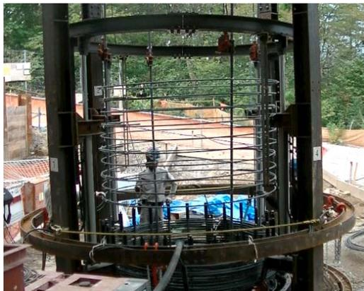
写真-10 フープ筋の設置状況
