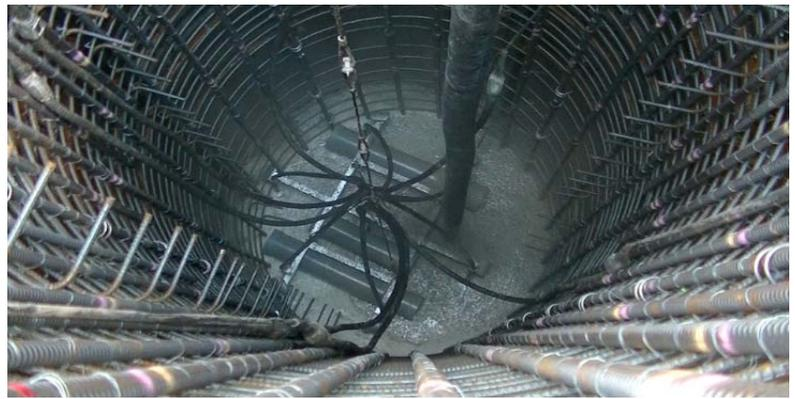
写真-13 塩ビフロートにバイブレータを設置した締固め状況
