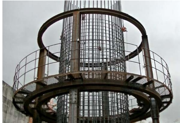
写真-11 残りの主筋の建て込み状況
