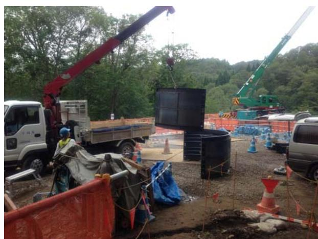
写真-7 H26年度土留の杭頭での組立状況
