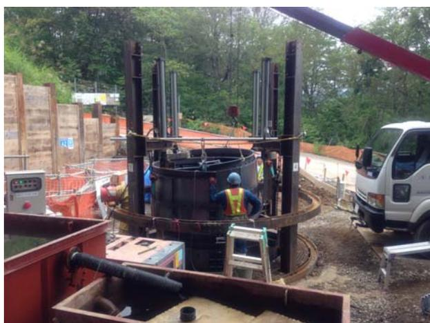
写真-6 H26年度孔外土留（1リング）組立後の2分割状況
