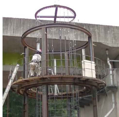
写真-9 孔外で組立てた鉄筋籠の建て込み状況
