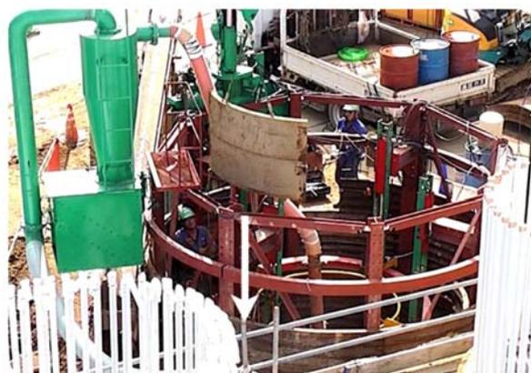
写真-5 H24年度土留の杭頭での組立状況
