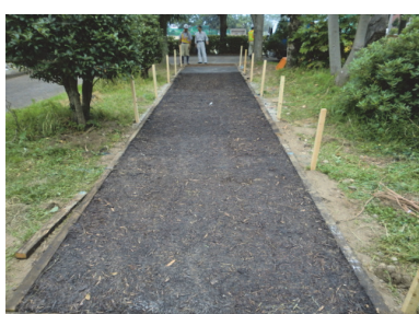
写真-10 施工完了
