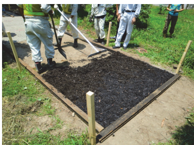
写真-8 敷きならし状況
