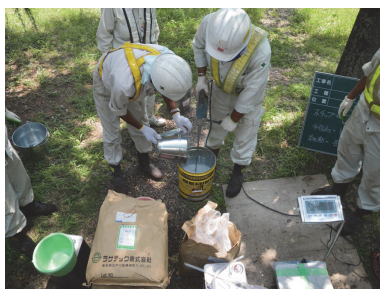
写真-6 攪拌状況②
