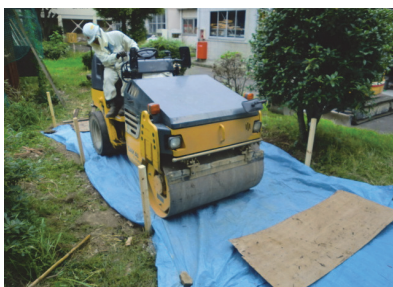
写真-9 転圧状況
