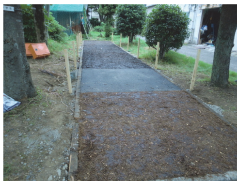
写真-11 岐阜高専中庭の各種舗装
