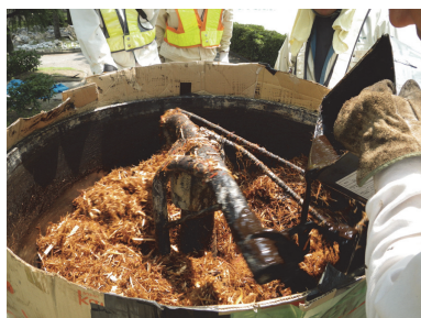
写真-5 攪拌状況①
