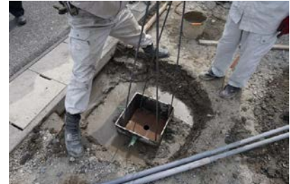
支柱底板プレートの設置
