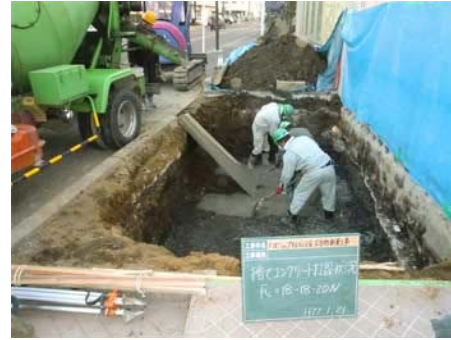
砕石の敷設・基礎コンクリートの打設
