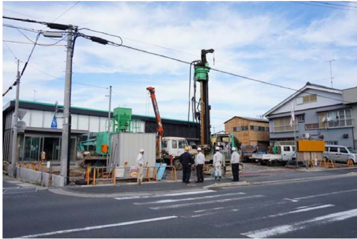
写真-4 施工現場全景
