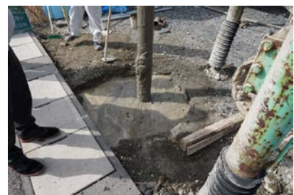
セメントの注入攪拌
