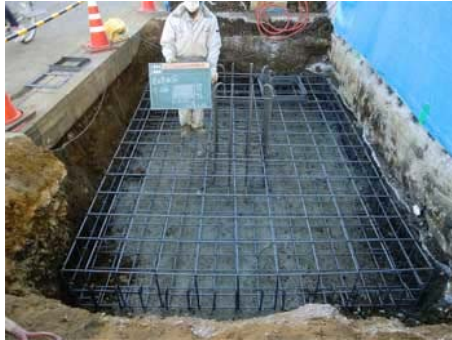
鉄筋の組込み
