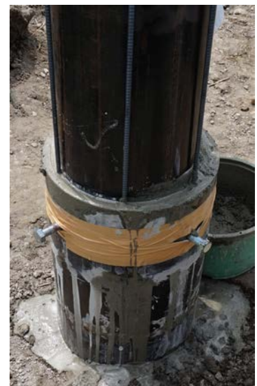
写真-3 支柱-杭結合構造
