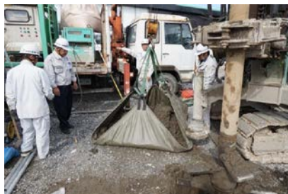
現地発生土(上部 1m 程度)の搬出
