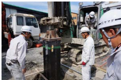
改良体への杭の立て込み
