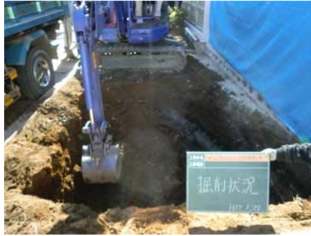
バックホーによる掘削
