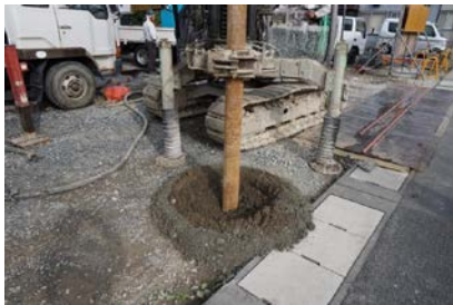
オーガーによる地盤の掘削
