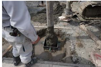
杭上部の中掘り(1.5m)
