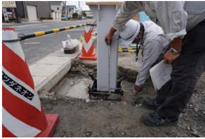
支柱の立て込み
