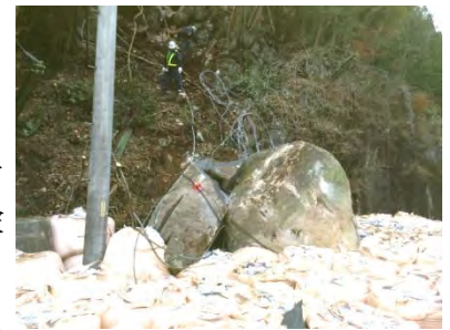
図-14 土のうへの衝突後の様子
