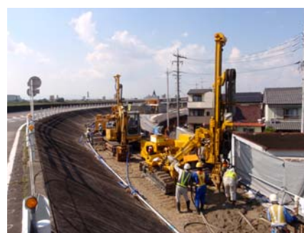
写真-4 施工状況
