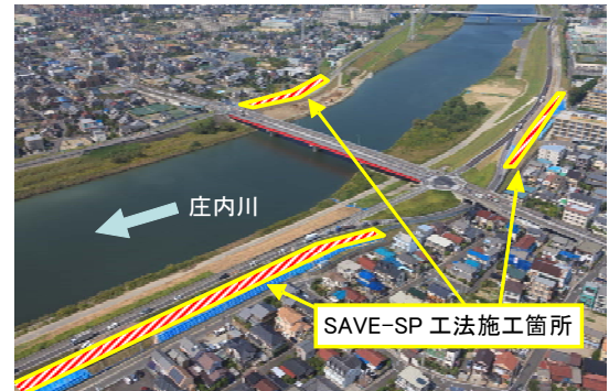
写真-1 施工箇所の一例
