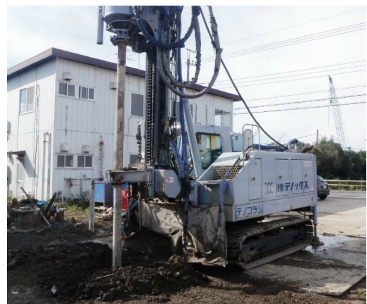
写真-1 試験コラム築造状況
