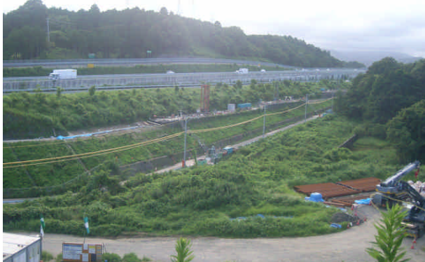
写真-1 鋼管ぐい施工状況
