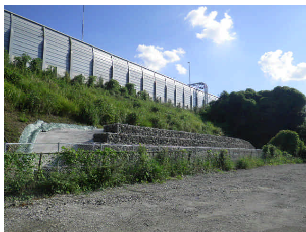
写真-2 鋼製かご枠施工状況
