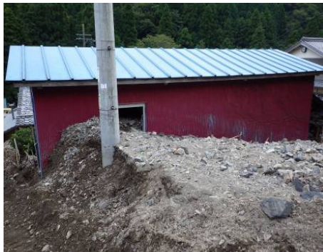
写真-6 未倒壊家屋
