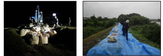
名古屋市では、長戸川右岸の堤防からの越水箇所(延長:130m)において、名古屋市消防局及び災害派遣で出動した自衛隊により、土のう積みみを9月21日0:40に着手し、同日8:00に完了。
