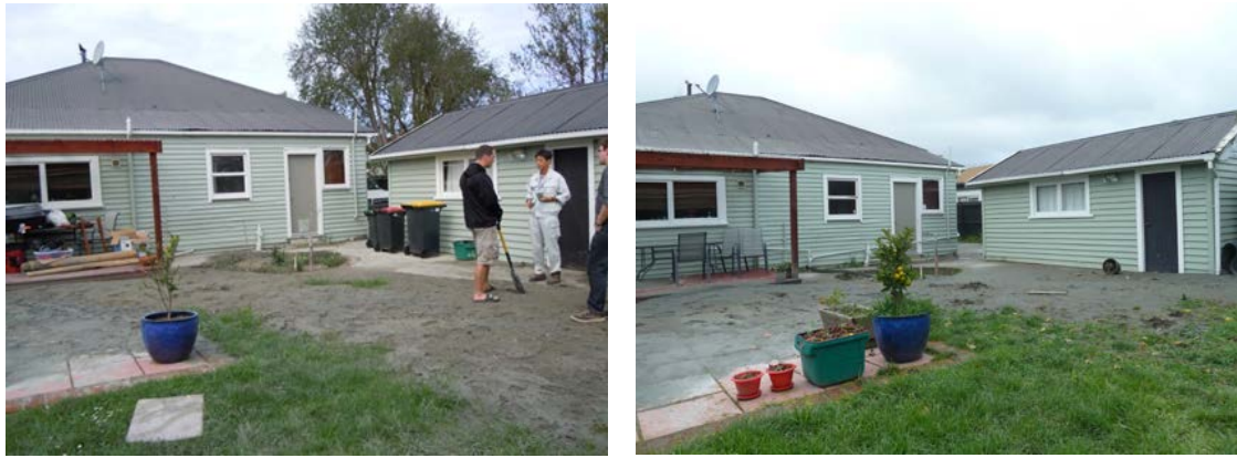
写真 8 繰り返し噴砂が確認された Avonside の住宅 (左：Darfield 地震後*)、右；6 月の余震後)
