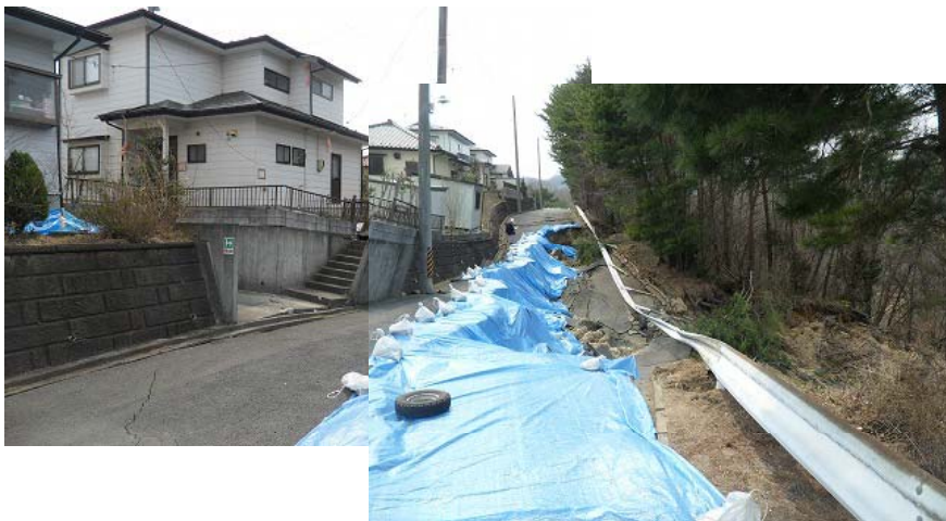
斜面崩壊(斜面F)
