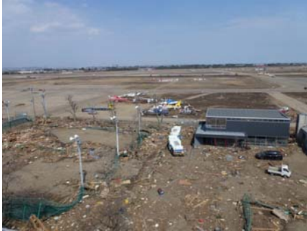
調査日(3/29)現在の滑走路の様子
