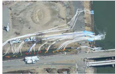
国交省による排水作業の様子 東北地方整備局HPより
