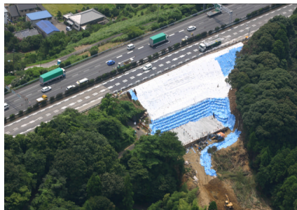
図-3 応急復旧完成後
