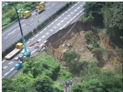
図-2 盛土被災状況
