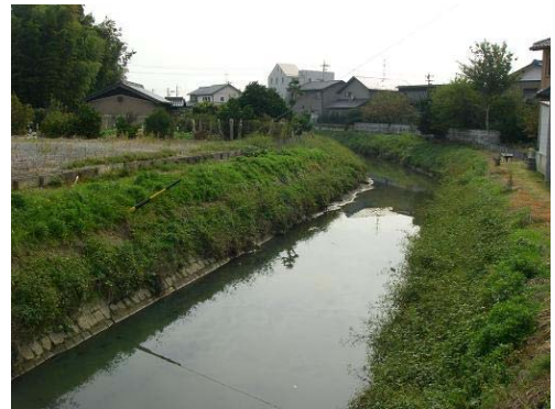
写真-1 実証試験場所の全景 (岐阜県羽島市竹鼻町)
