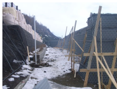
写真-5. 施工中 (ポケット部)
