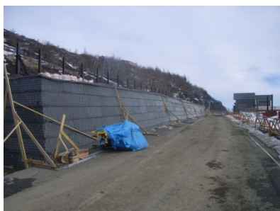
写真-4. 施工中 (正面側)
