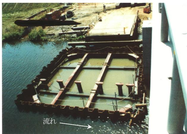
写真-2 ボイリング後の仮締切の状況
