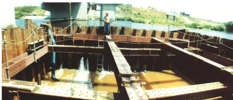
写真-3 矢板からの漏水状況
