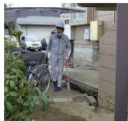
周辺地盤の沈下による建物基礎との段差
