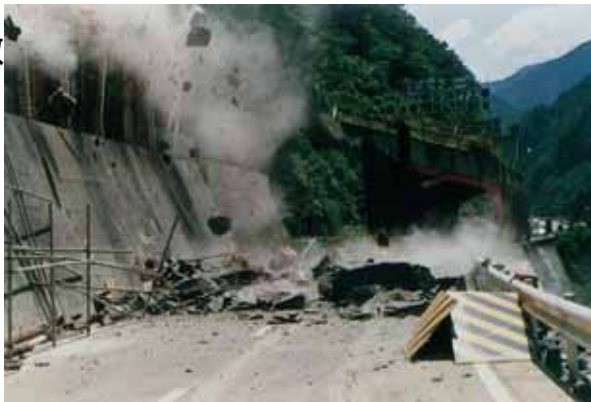
1979年7月 一般国道33号 愛媛県上浮穴郡柳谷村
