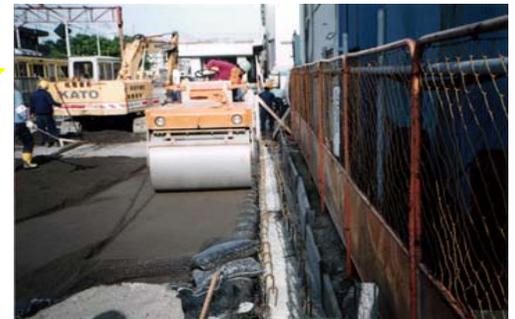
2004年台風23号によるテールアルメ補強盛土の被害
