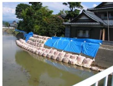
鯖江市落井町での擁壁護岸の損壊
