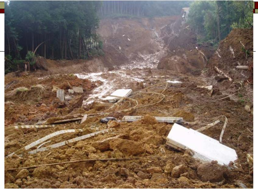
崩壊土砂上のコンクリートスキンの散乱状況
