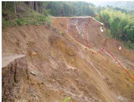
崩壊盛土の西側の破断面の詳細；破断面においてもストリップ自体に破断の形跡はない。また、全体的にストリップの根元付近が斜め下を向いている
