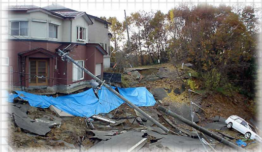
住宅盛土の崩壊の様子（建築研究所被害速報より）
