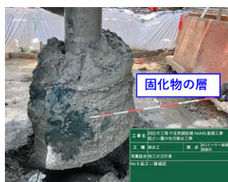
図-3 固化物引き上げ
