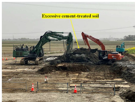
図-1 現場におけるセメント改良作業と過剰改良土の発生状況
