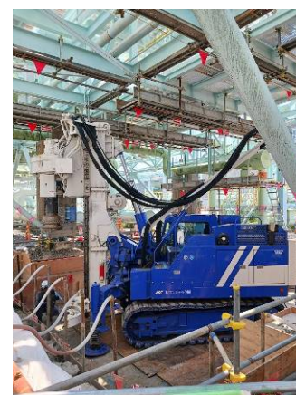
図-6 回転杭打設状況
