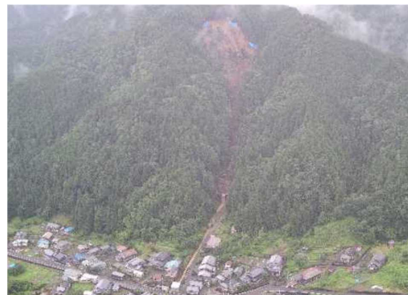
写真-2 奥田洞谷の災害(R2年7月) 2)
