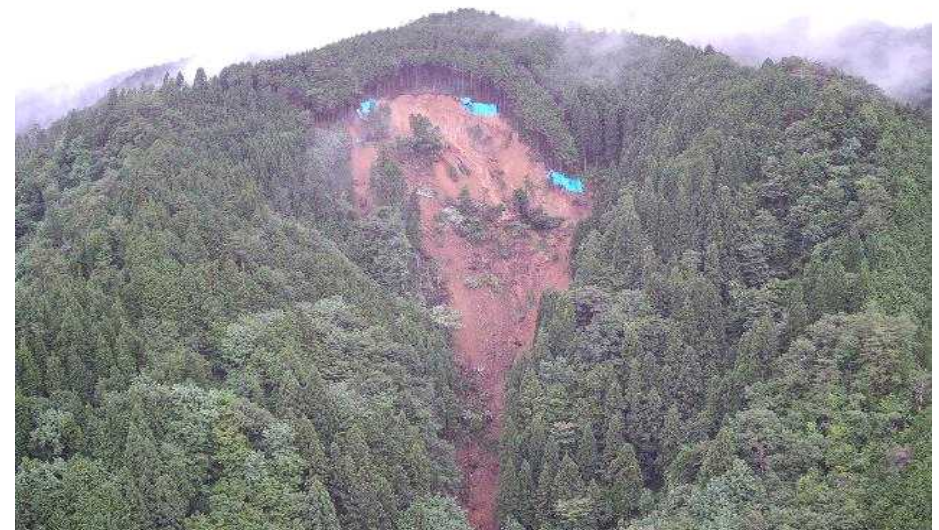
写真-4 第2回崩壊後[令和2年7月8日撮影]
