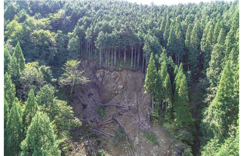
写真-3 第1回崩壊後[平成30年9月28日撮影]
