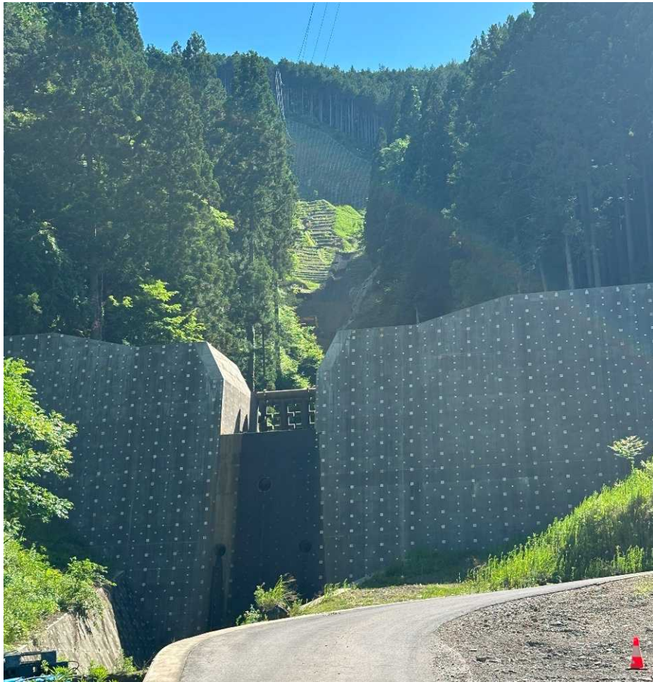
砂防堰堤の嵩上げ
