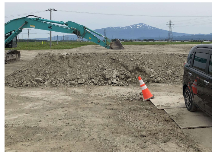
盛上り土の余剰分の一時保管
