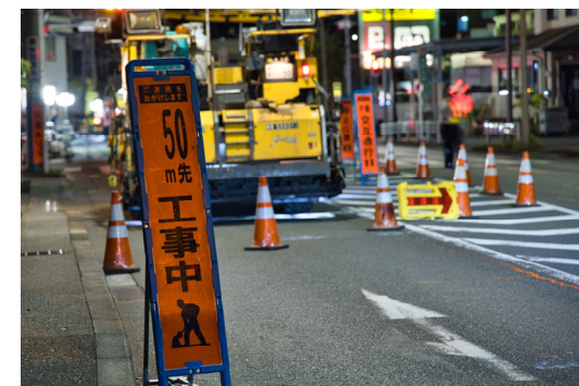
道路規制、立入規制の様子
