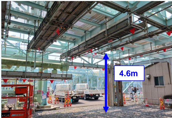
施工状況(施工地盤の切り下げ後)
