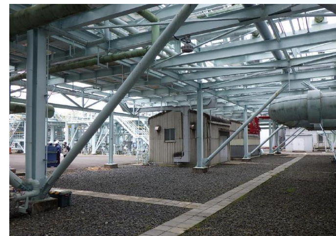
② 基礎構築箇所
