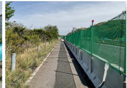
路肩固定規制設置状況
