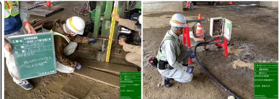
パイプひずみ計設置状況
