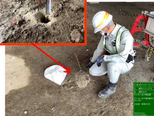
地表面沈下量測定（アンカー沈下棒）概要
