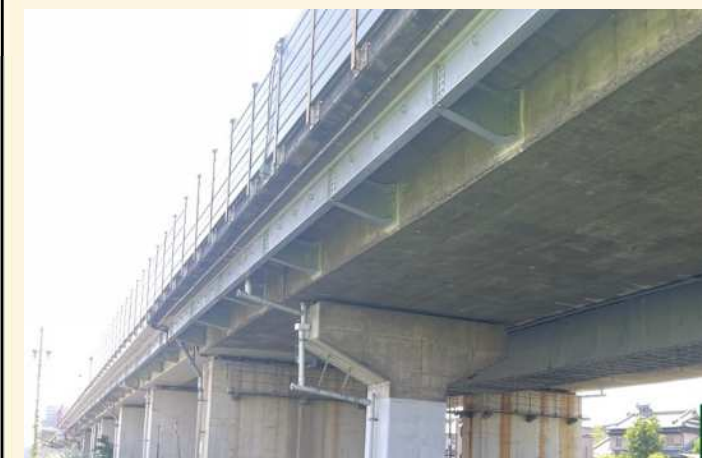
ブラケット・縦桁設置状況
