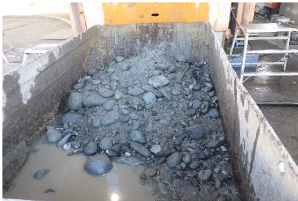
基礎杭掘削土砂
