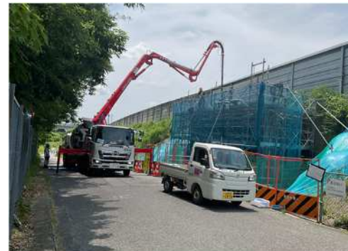
ボックスカルバート拡幅状況
