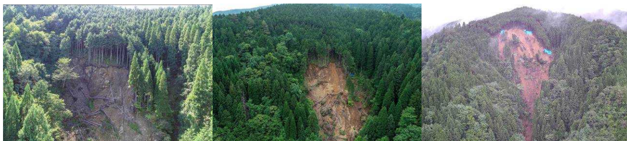
写真-1 奥田洞谷の崩壊写真（左：第1回崩壊後 [平成30年9月28日撮影]，中央：クラック発生時 [令和2年6月15日撮影]，右：第2回崩壊後 [令和2年7月8日撮影]；岐阜県提供資料）
