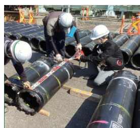
図-5 短尺の鋼管杭（2m分割）
