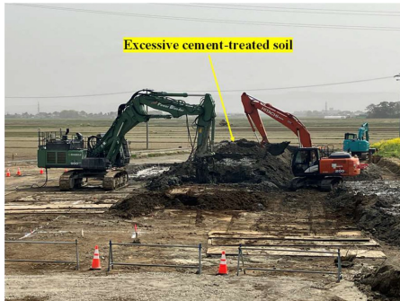
図-1 現場におけるセメント改良作業と過剰改良土の発生状況
