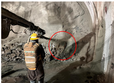
写真-1 吹付けサンプル作製
