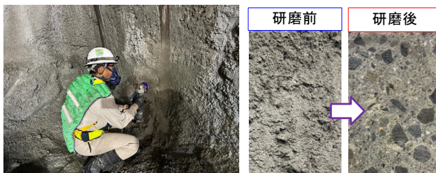
写真-4 吹付け面研磨状況
