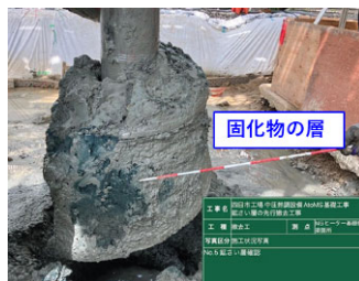
図-3 固化物引き上げ
