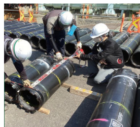
図-5 短尺の鋼管杭（2m分割）
