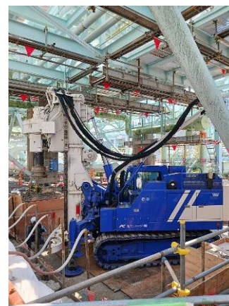
図-6 回転杭打設状況
