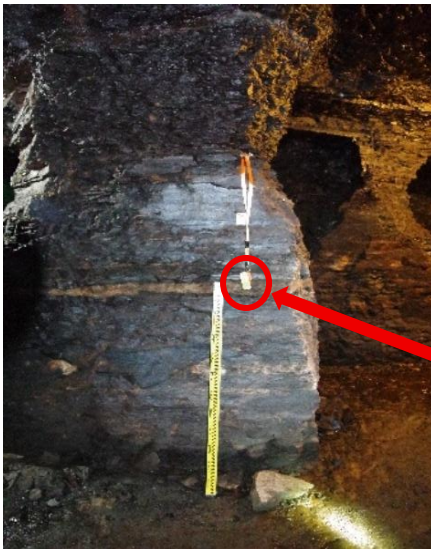
図5 亜炭廃坑出入口に設置したデータロガー
