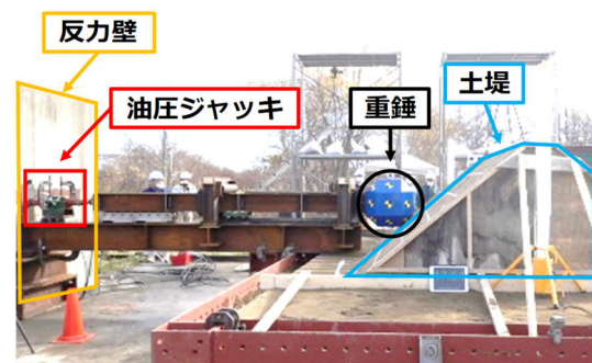
図 2 実験風景写真（中型土堤）
