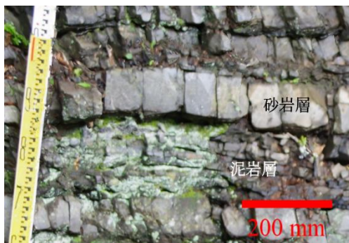
図7 砂泥互層の露頭の一部
