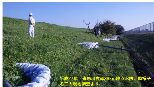
図1 漏水対策型水防工法の様子(月の輪工)
