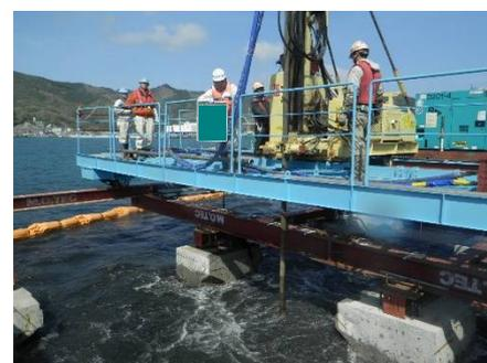
写真-4 簡易的なブロック積仮設状況
