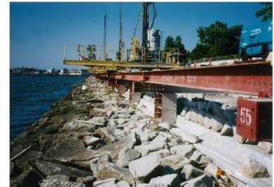
写真-1 被災した護岸部捨石層状況と軽量小型単相式高圧噴射工法の適用
