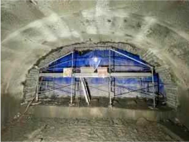
写真-1 上り線 上部取り壊し完了状況
