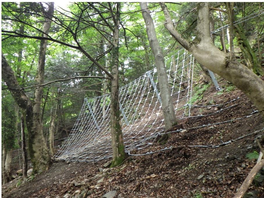
写真-1 落石減勢工完成写真
