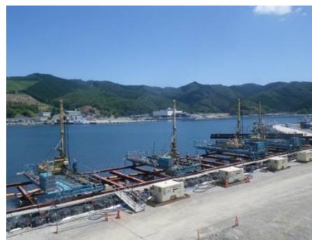
写真-3 岸壁補強施工状況
