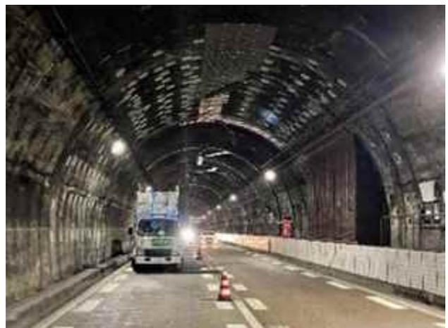
写真-4 供用トンネル 追加補強ロックボルト打設完了
