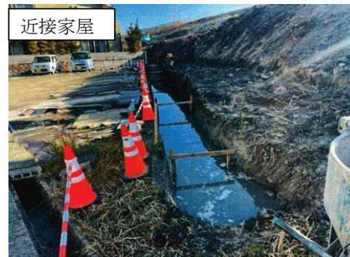
図-5 川裏法尻掘削時の湧水
