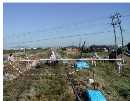
写真-5 河川堤防のり面の側方流動
