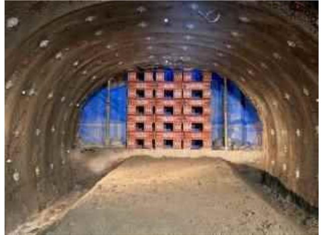
写真-2 サンドルによる補強状況
