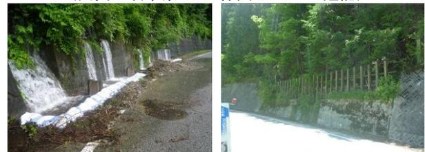
写真-2 流域K57(左 被災写真, 右 擁壁上の落石防護柵)
