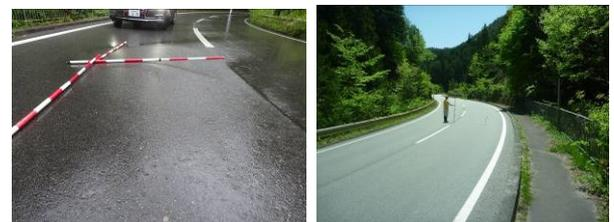
写真-5 参考 流域 R06 舗装隆起災害 (左被災時, 右補修後)
