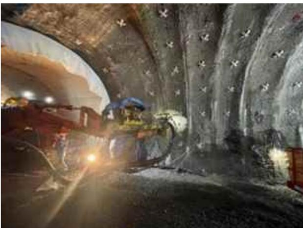
写真-3 避難連絡坑 追加補強ロックボルト施工状況
