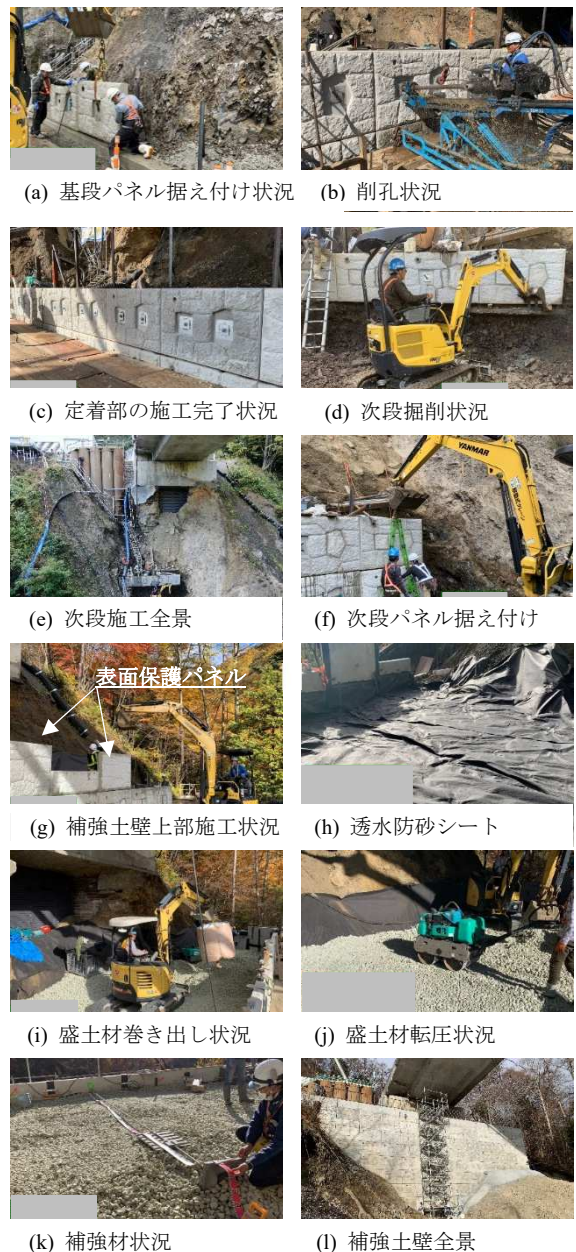
写真-2 施工の状況写真
