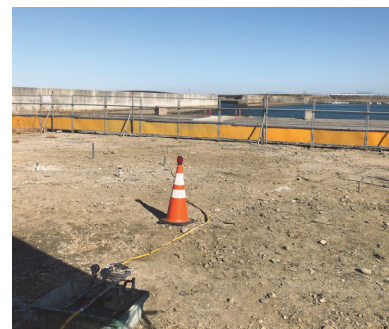
写真-2 実験ヤード
