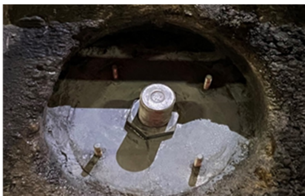
写真-3 頭部キャップ取り外し後の様子
