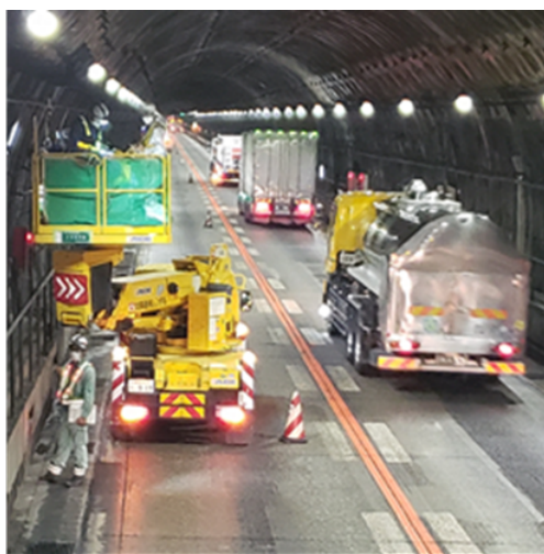
写真-2 交通規制下のトンネル内計測の様子
