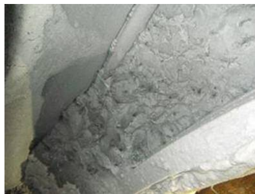
写真-2 凍結運転中の切羽状況
