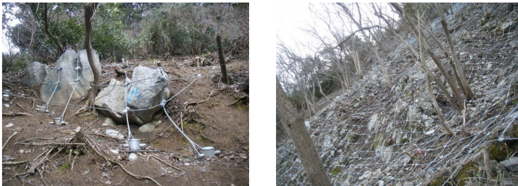
写真-1 掛工(左) 伏工(右)
