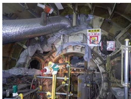
写真-2 凍結運転中の切羽状況
