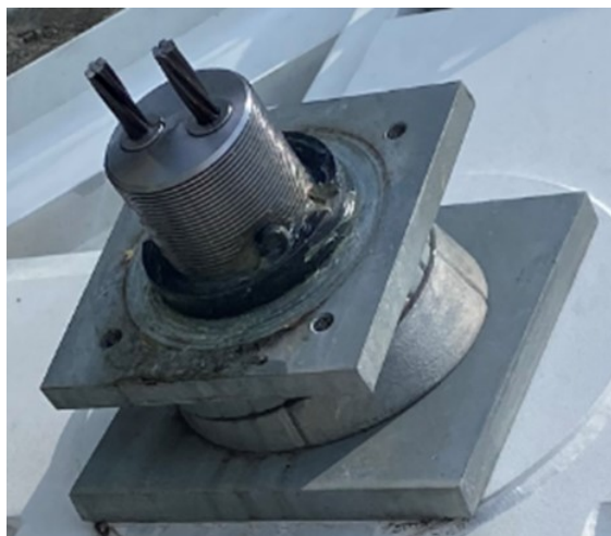
写真-1 頭部キャップ取り外し後の様子
