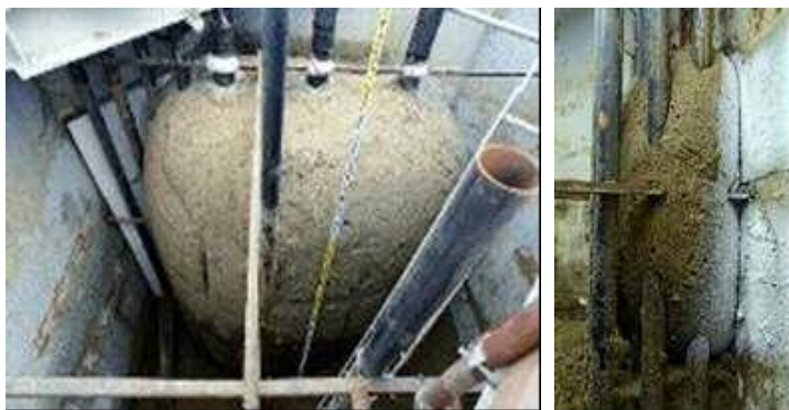
図-9 掘り起こした凍土(左:鉛直凍結 右:貼付凍結)
