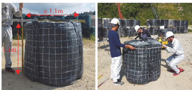
写真3 大型土のうの概観
