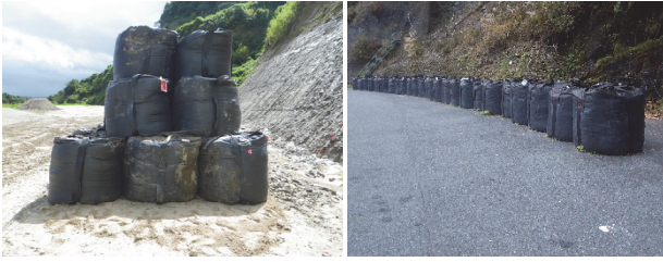
写真5 大型土のうを用いた仮設防護施設の設置事例
