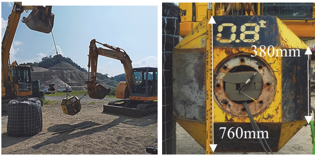
写真1 重錘吊上げ状況
