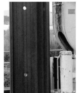
写真-2 透水性鋼矢板
