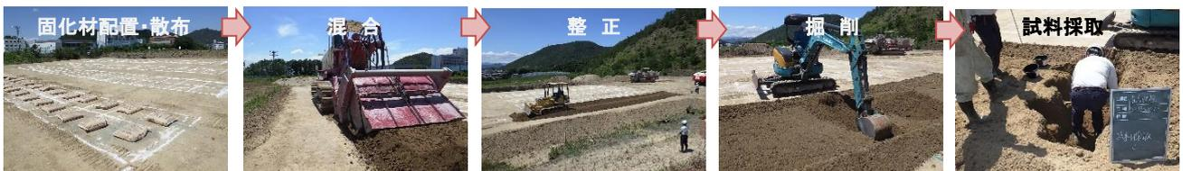
図-2 混合精度試験状況 (STB0.7)
