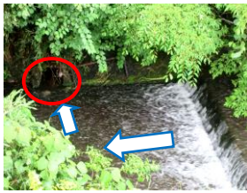
写真 13 一軒川取水口
