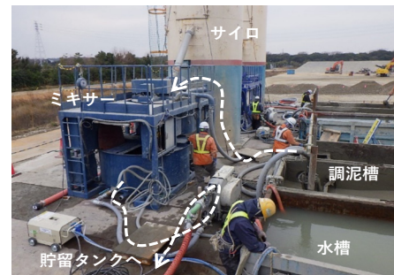
写真 3 現場導入プラント
