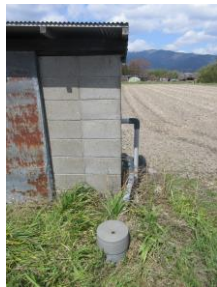
写真 18 ポンプ井戸 (マンボE付近)
