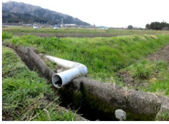
写真 17 集水用暗渠の吐口 (マンボB付近)
