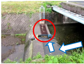
写真 15 一之谷川取水口
