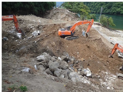
図-2.2.7 JR 盛土崩壊箇所
