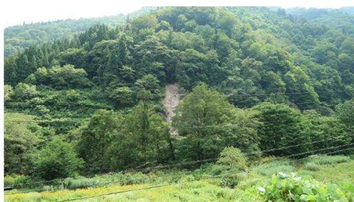
図-2.1.7 月ヶ瀬2の被災状況（全景）
