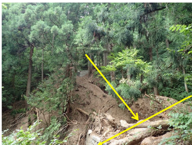
図-2.3.6 A沢における土砂流出の様子
