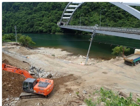
図-2.2.5 JR 盛土下流側
