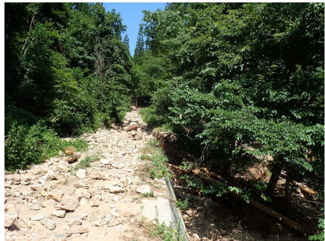
図-2.4.8 堰堤上流の作業道の様子②
