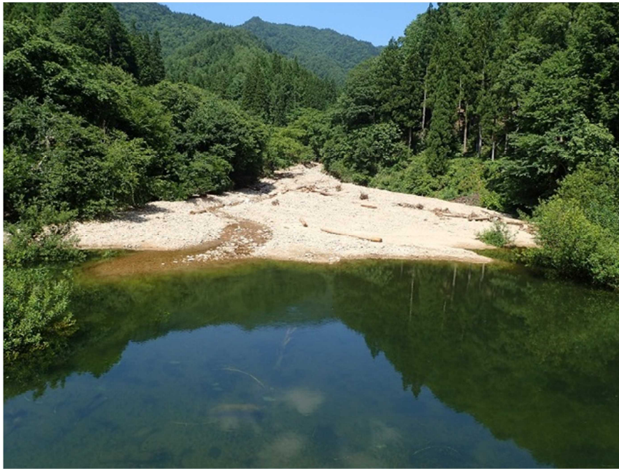
図-2.4.6 砂防堰堤上流側の様子
