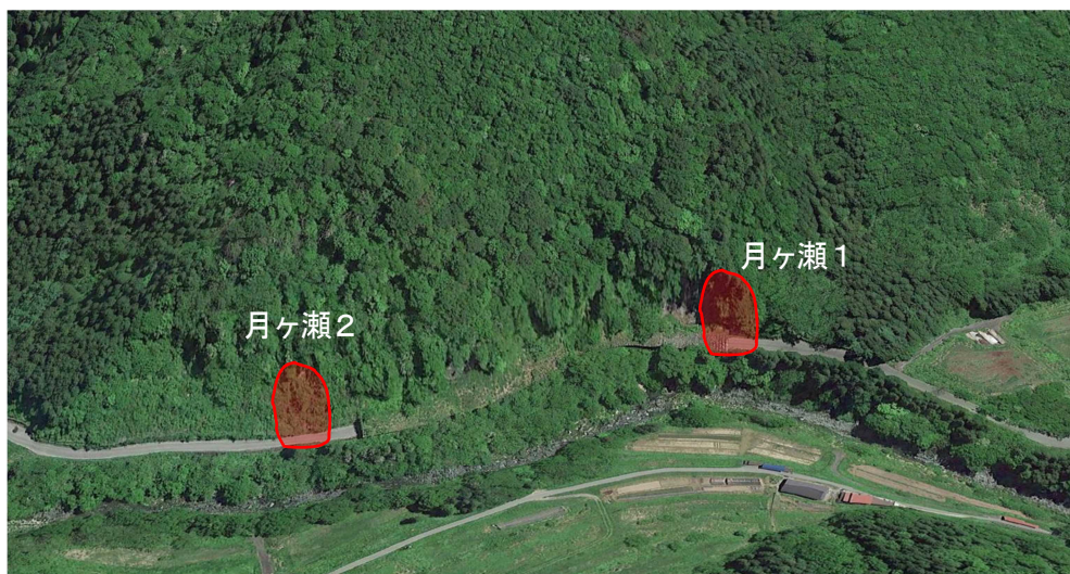
図-2.1.3 被災前の状況（Google Earth）
