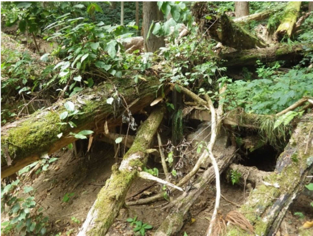
図-2.3.8 B 沢直下にある防護柵
