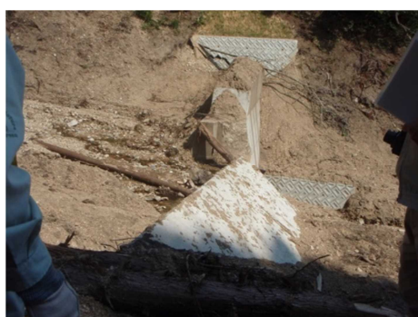
図-2.5.5 損傷した治山堰堤
