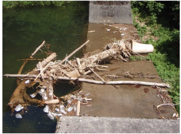
図-2.4.10 堰堤で捕捉されていた流木
