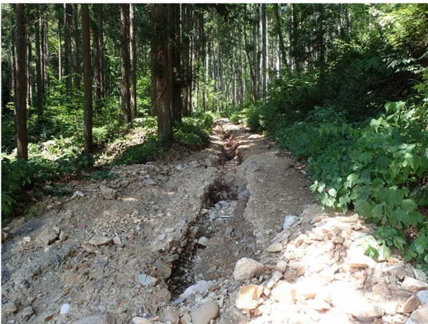
図-2.4.7 堰堤上流の作業道の様子①
