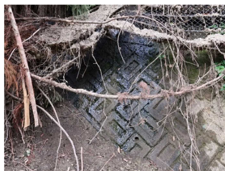
図-2.1.6 崩壊地末端部（林道）
