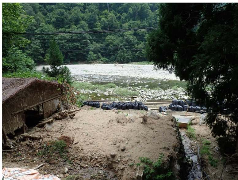
図-2.3.5 林道から沢の下流部（土砂流出現場）を望む
