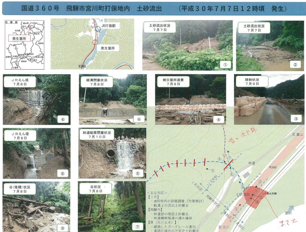
図-2.3.4 被災状況（岐阜県古川土木事務所提供資料）
