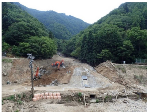
図-2.2.4 被災箇所の現況
