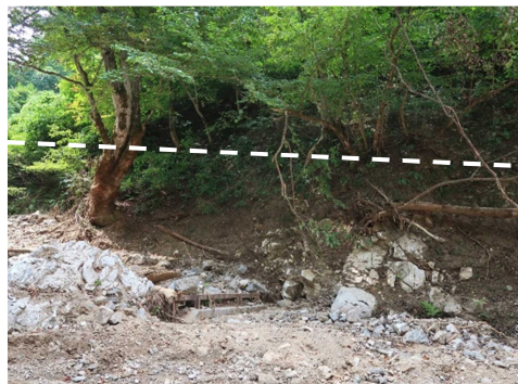
図-2.2.9 上流部の側部（左岸側）
