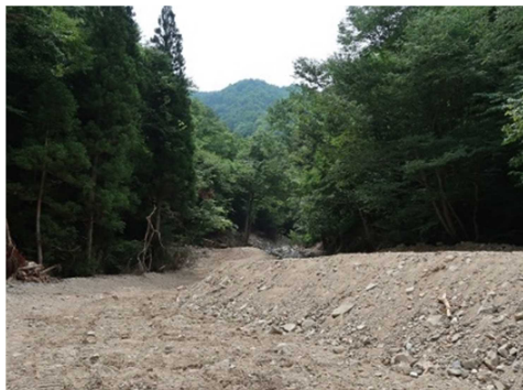
図-2.2.8 土石流跡（最上流部）
