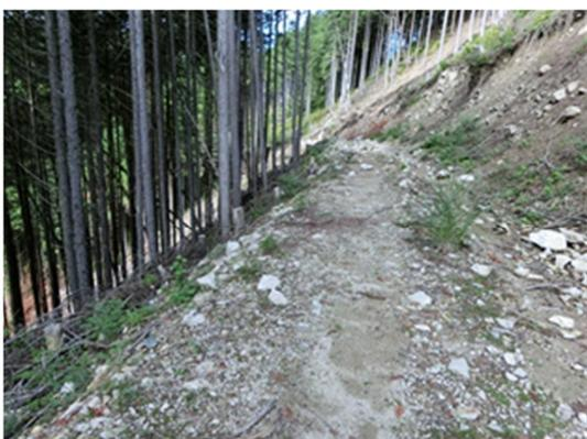
図-2.1.12 林道(下方)の路面に侵食痕無し
