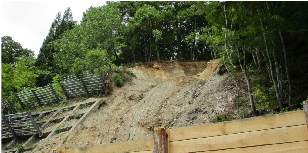
図-2.2.4 下から崩壊部を取った写真
