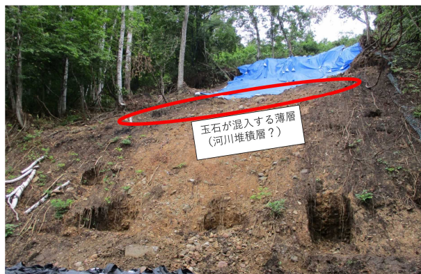
図-2.5.6 崩壊のり面
