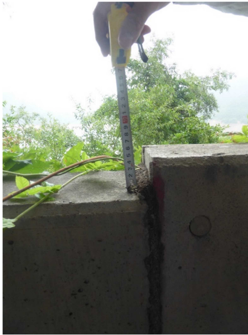
図-2.4.2 スノーシェッド内の変位
