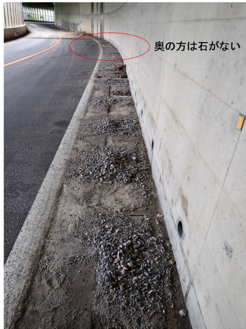
図-2.3.7 スノーシェッド内の排水設備
