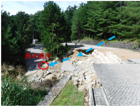
図-2.1.7 崩壊時の湧水箇所
