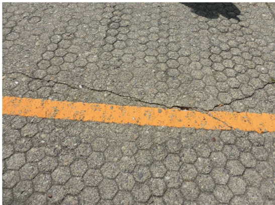
図-2.1.11 コンクリート舗装の亀裂
