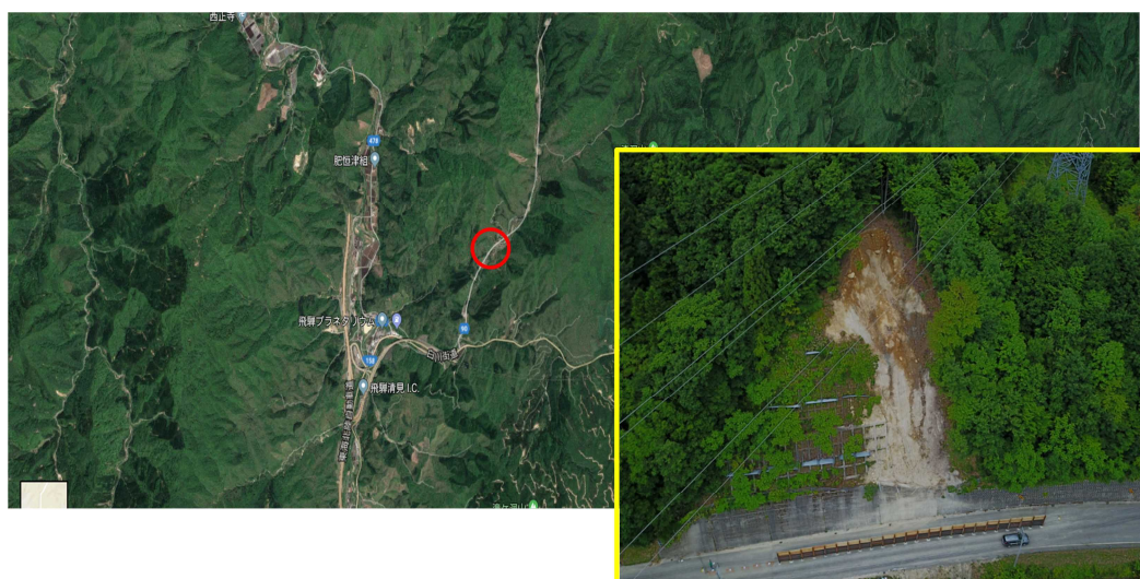
図-2.2.3 被災前の様子 (Google Earth より) と地すべりの様子 (ドローンにより空撮)
