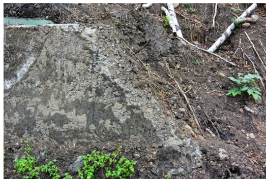
図-2.5.4 崩壊したコンクリート擁壁
