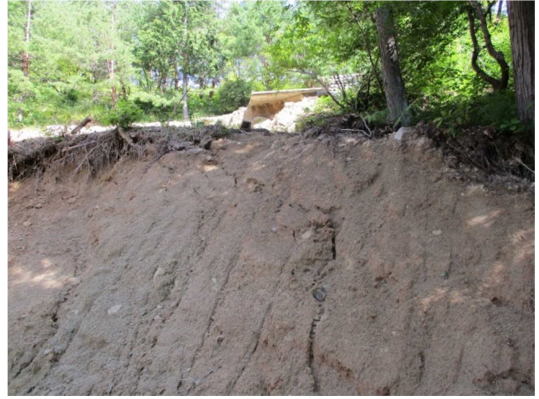
図-2.1.10 崩壊土砂の様子
