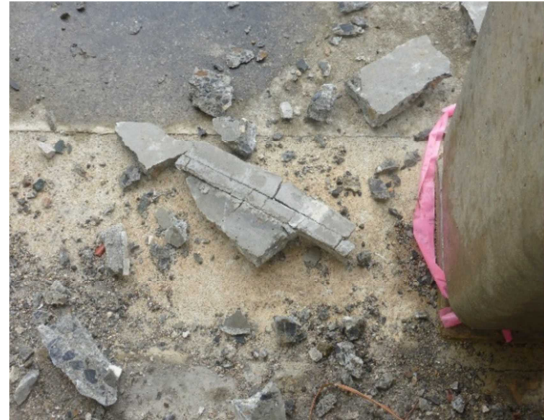
図-2.3.8 スノーシェッドの柱と破片
