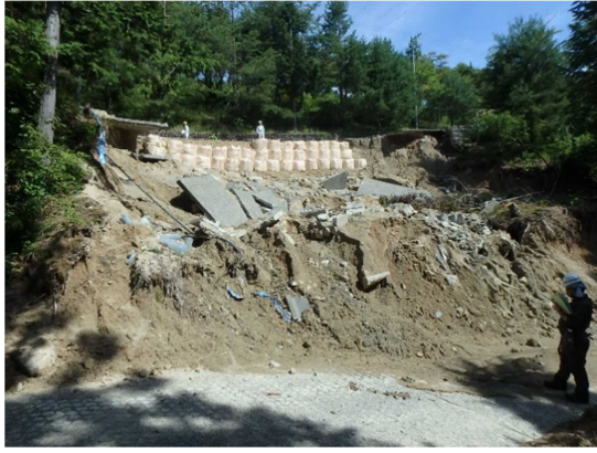
図-2.1.5 崩壊箇所の全景
