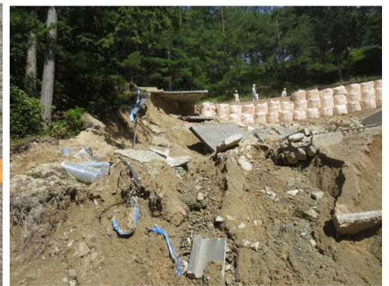
図-2.1.12 排水設備の損傷
