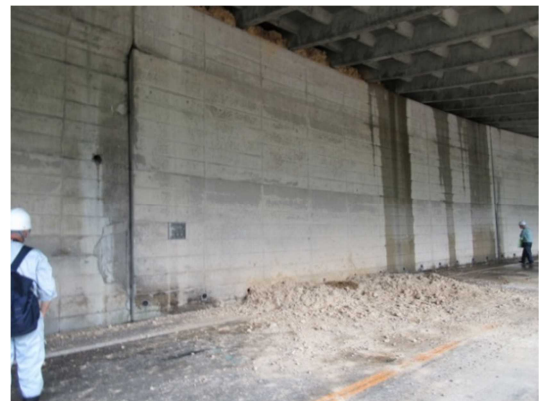
図-2.3.5 スノーシェッド内の様子2（崩落直下）
