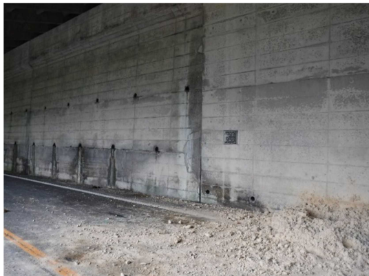
図-2.3.4 スノーシェッド内の様子1
