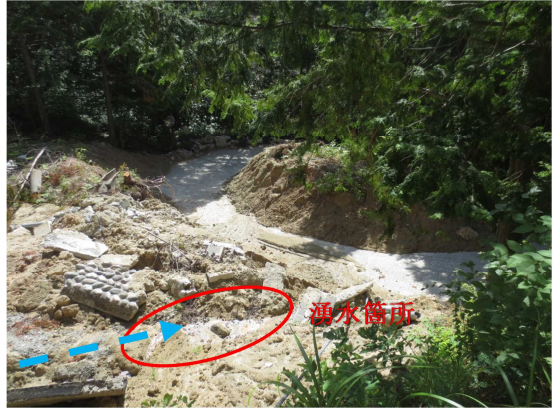
図-2.1.8 崩壊時の湧水箇所（上から見た）
