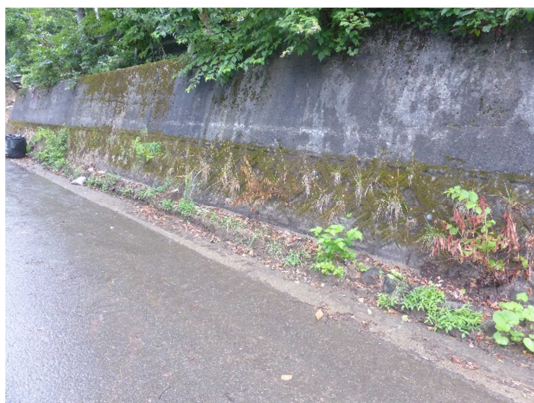
図-2.5.5 崩壊しなかったコンクリート擁壁
